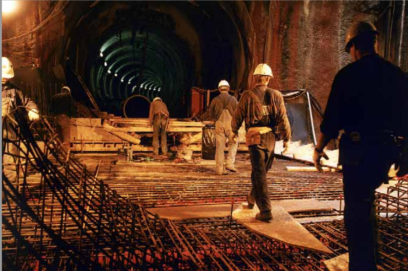
Skakt ved Stadsgraven
